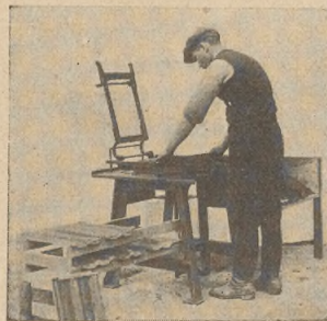
Maszyna dachówkowa podczas pracy
